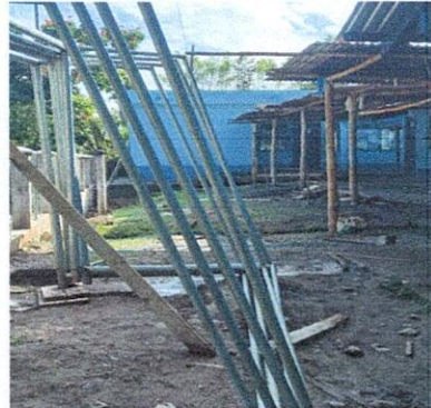
Foto 2: Muro de Contención Frontal
