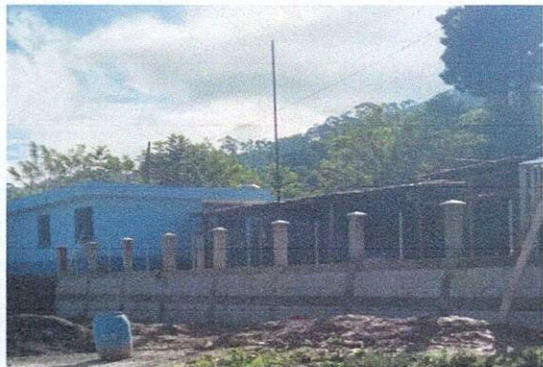
Foto 1: Muro de Contención Frontal
